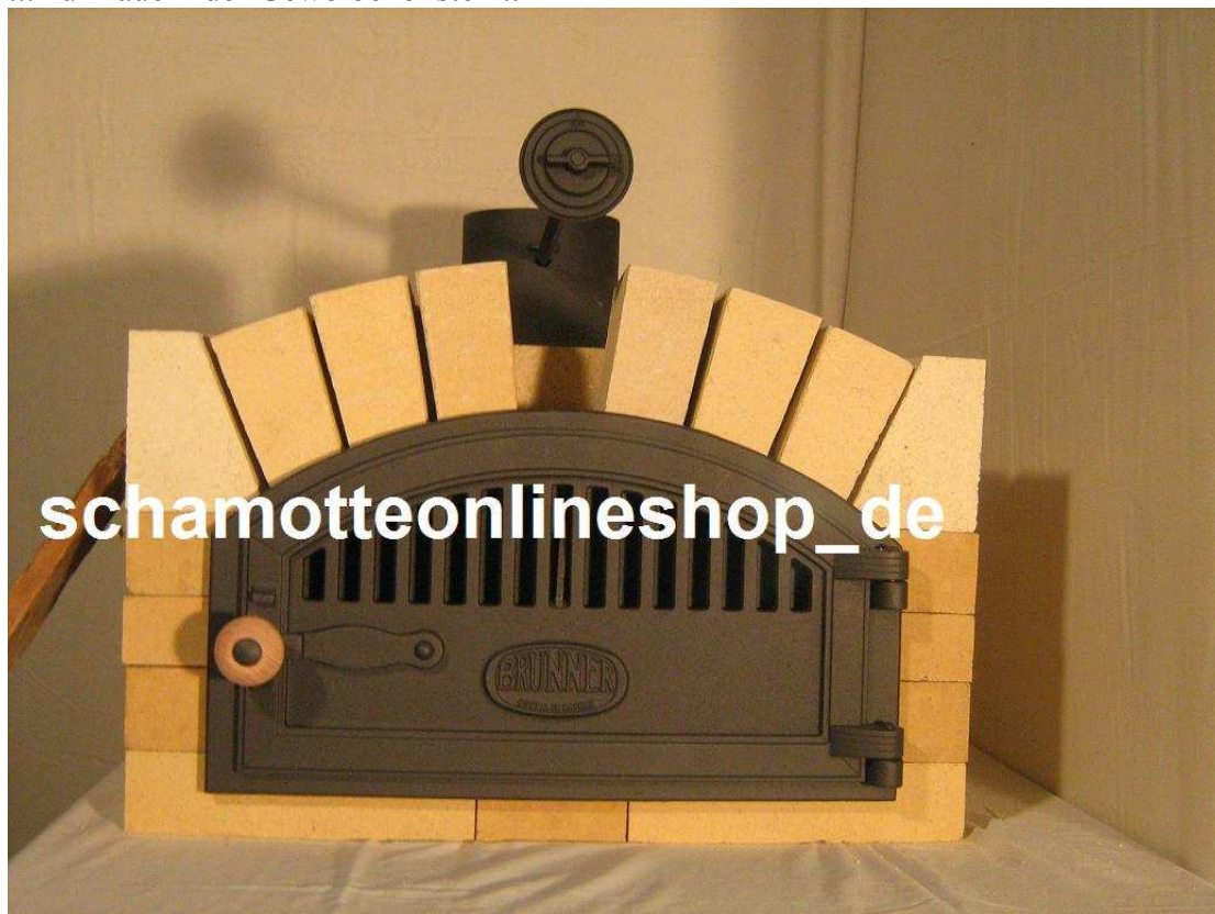
...Aufmauern der Gewölbekeilstein..
