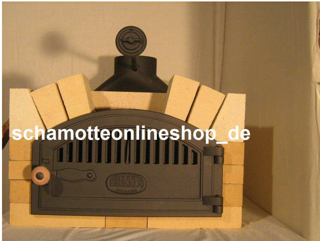
...Aufmauern der Gewölbekeilstein..
